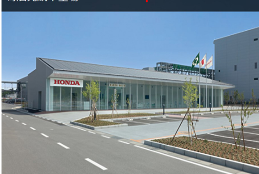
寄居完成車工場 YORII plant
